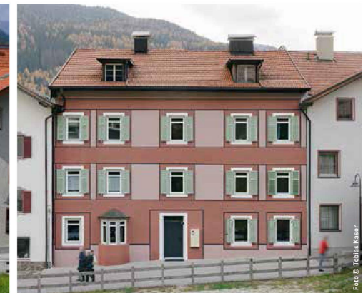
... und dieselbe Ansicht nach der Sanierung
